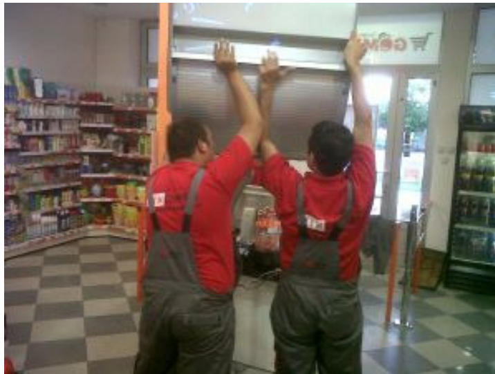
Montaža u prodajnom objektu
