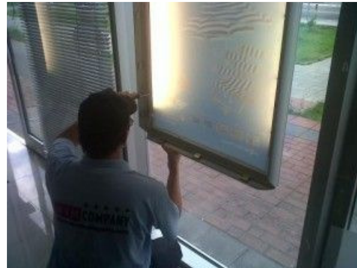
Montaža u filijali banke
